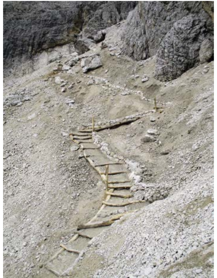
Bei der Langkofelscharte wurde die Trasse neu definiert und ausgearbeitet.
