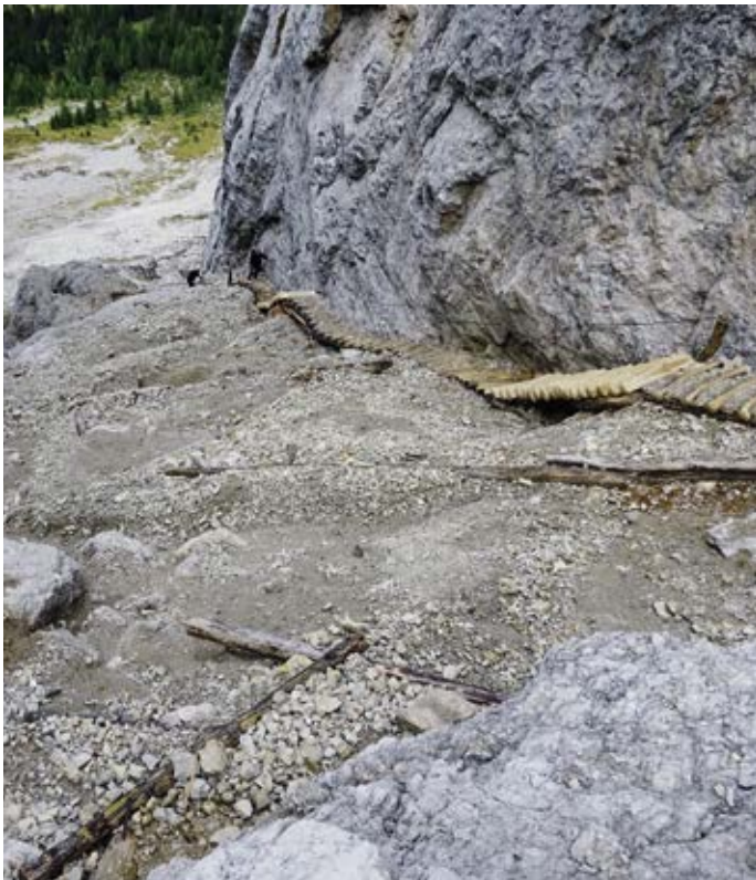
Viele neue hilfreiche Treppen wurden auf der Panascharte angelegt.
