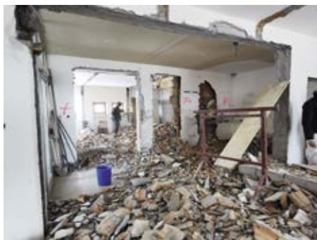
Die Büros werden saniert und modern eingerichtet.
