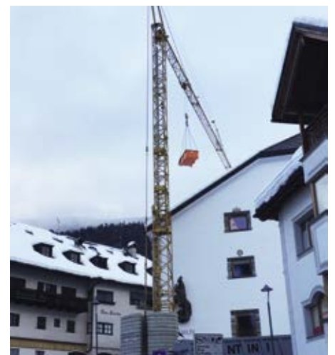
Der Kran über dem Gemeindehaus
